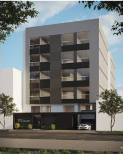
Edificio Alvarado CHORRILLOS
