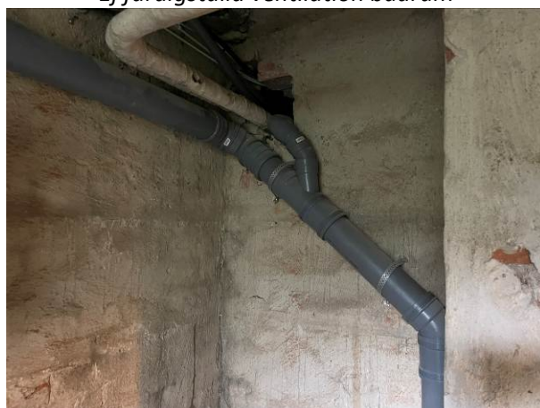
Delvis bytta VA-installationer kv
