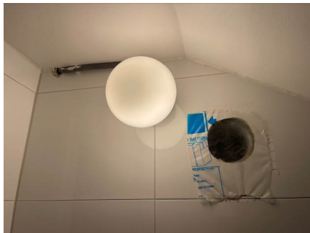
Ej färdigställd ventilation badrum
