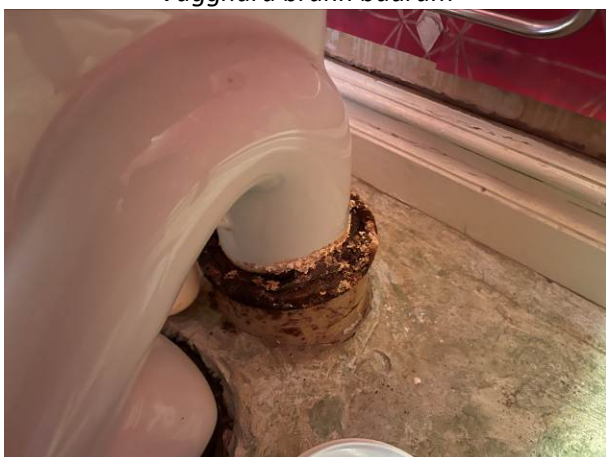
Ej bytt avloppsledning wc bv
