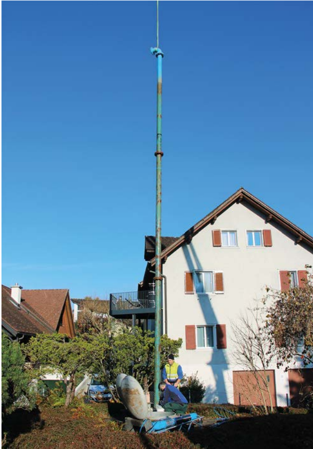
Auswechseln einer defekten Grundwasserpumpe
