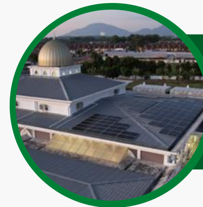
MASJID ABU UBDAIDAH SIMPANG AMPAT, PULAU PINANG 55 kWP
