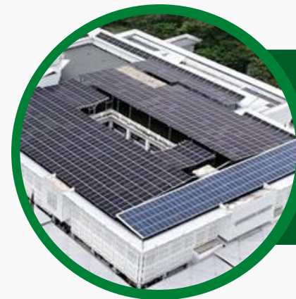
MASJID RAJA HAJI FISABILILLAH CYBERJAYA, SELANGOR 500 kWP
