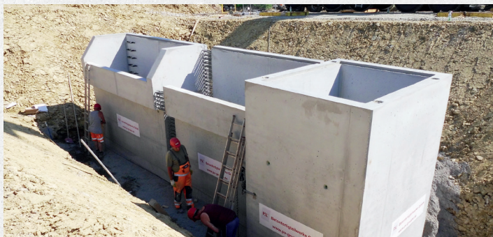
Rückhaltebecken mit Entlastungsbauwerk
