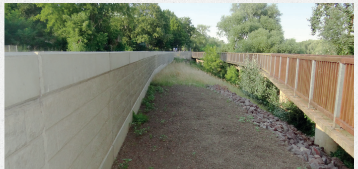
Hochwasserschutzmauer entlang der Elbe, Oststraße Magdeburg
