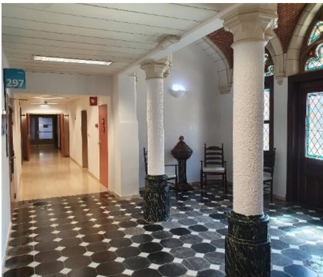
In de inkomzone bleef de marmervloer bewaard, evenals de zuilen met marmerimitatieschildering op de sokkels. Onder de fraaie baksteengewelven zijn spitsboogopeningen gemaakt, ingevuld met schrijnwerk waarin gekleurd glas in lood.
