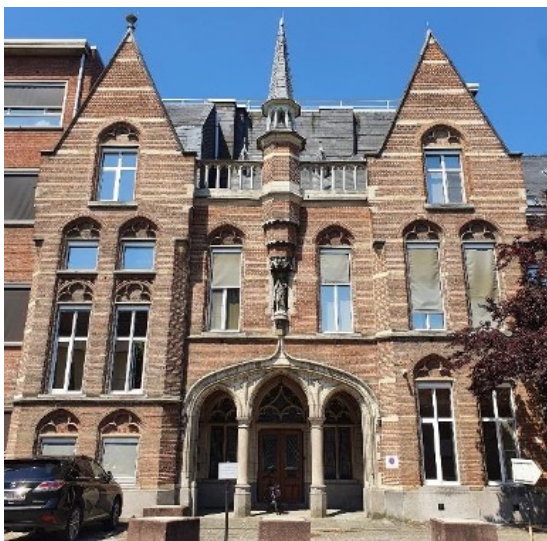
Detail van het inkomvolume, waarbij het dak zwaar werd aangepast tijdens de bouw van de vleugel links ervan. Centraal onder het bekronend torentje bevindt zich een neogotisch baldakijn met beeltenis van het Heilig Hart. De hoek tussen beide historische vleugels is een verzameling van aan elkaar geschakelde variabele volumes uit verschillende periodes.
