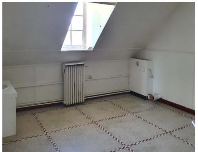
Voorbeeld van een van de gangen, met gestandaardiseerde houten paneeldeuren en gemakkelijk afwasbare wandtegels en terrazzovloer. De plafondhoeken zijn gebogen en bevatten ventilatieopeningen. Voorbeeld van een van de ziekenkamers, opnieuw met een terrazzovloer.
