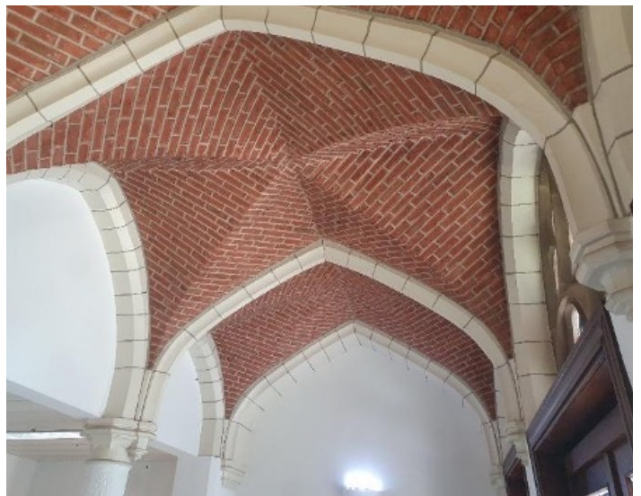
In de inkomzone bleef de marmervloer bewaard, evenals de zuilen met marmerimitatieschildering op de sokkels. Onder de fraaie baksteengewelven zijn spitsboogopeningen gemaakt, ingevuld met schrijnwerk waarin gekleurd glas in lood.
