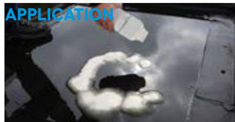
Répartissez les granulés autour de la zone humide que vous souhaitez réparer, de manière à créer une barrière. Laissez ensuite les granulés s'imprégnier pendant 3 à 5 minutes. Cela permettra de former un collier d'étanchéité solide autour de la zone à réparer, empêchant toute infiltration d'eau.
