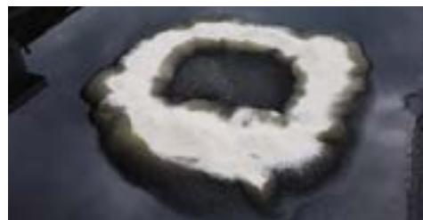
Si le support n'est pas complètement sec, vous pouvez également appliquer une fine couche de granulés sur la zone à réparer. Après la réparation, vous pouvez facilement aspirer ou balayer les granulés humides.
