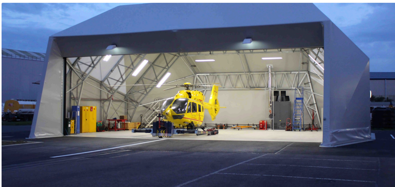
Fabspace-Hangar V_02 der East Anglian Air Ambulance am Cambridge City Airport – in zehn Wochen gefertigt, in zwei Wochen montiert. Foto: Fabspace Hangars GmbH
