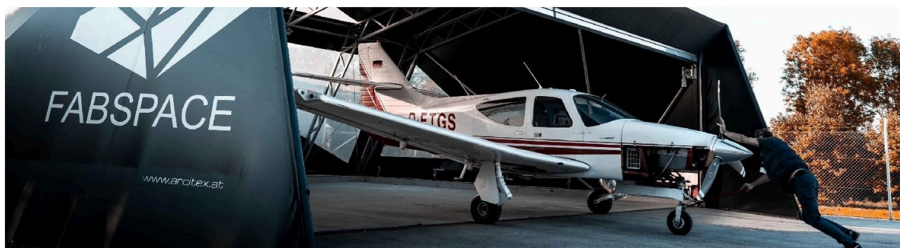
Platz für Flugzeuge der General Aviation bis zur Narrow-Body-Klasse: Fabspace-Hangar mit Membranfassade und Faltdor. Foto: Fabspace Hangars GmbH
