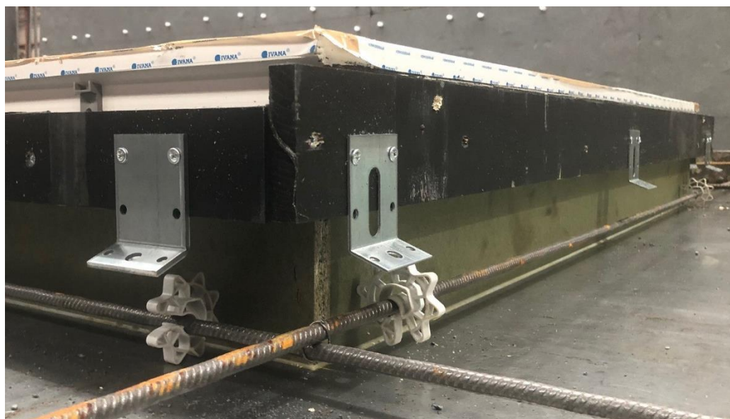
Kozijn ligt op de bekisting
