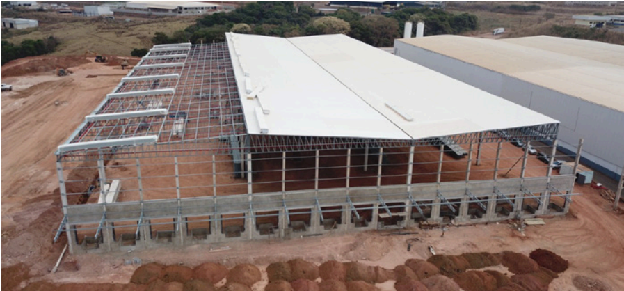
Vista Panorâmica do Galpão
