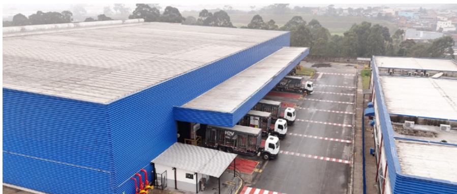
Ambev GRU - Área Externa
