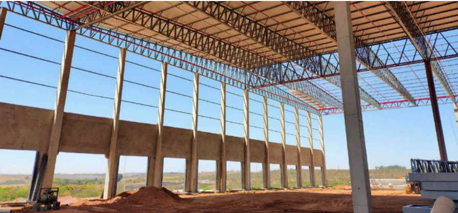
Vista Interna do Galpão
