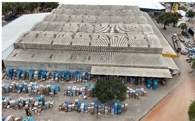
Vista aérea do pátio externo
