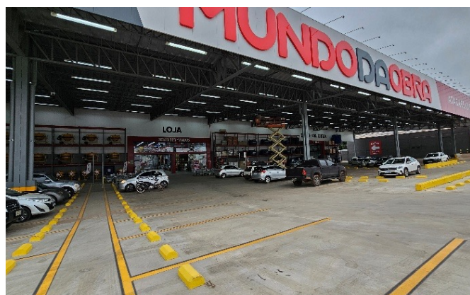
Estacionamento Mundo da Obra
