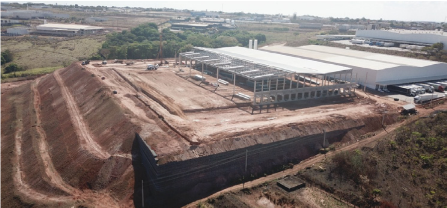
Vista aérea do Galpão
