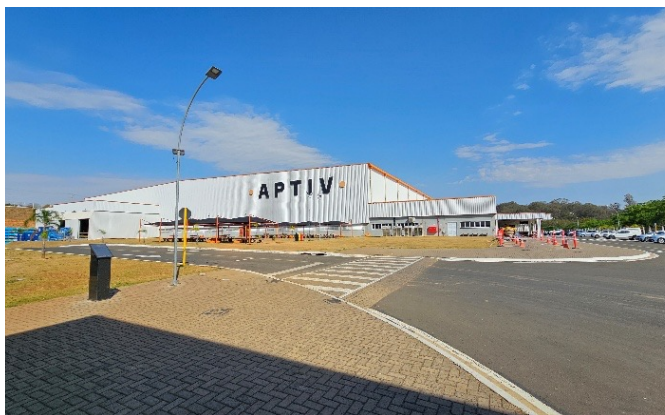
Galpão e circulação externa
