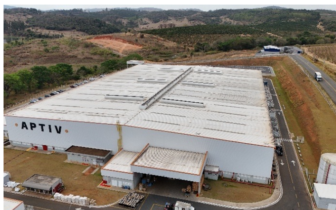
Vista aérea geral da fachada posterior
