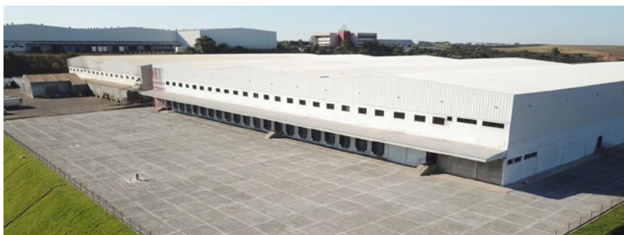
Área Externa do Galpão
