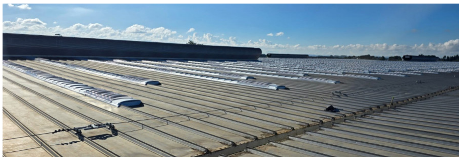
Cobertura do Galpão - Renault
