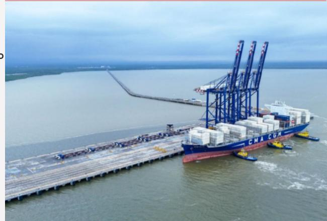
las condiciones geológicas particulares de la Región, se adoptó un diseño offshore innovador: un viaducto de 3,8 kilómetros conecta el patio en tierra con una plataforma marítima capaz de atender simultáneamente hasta cinco buques portacontenedores.
