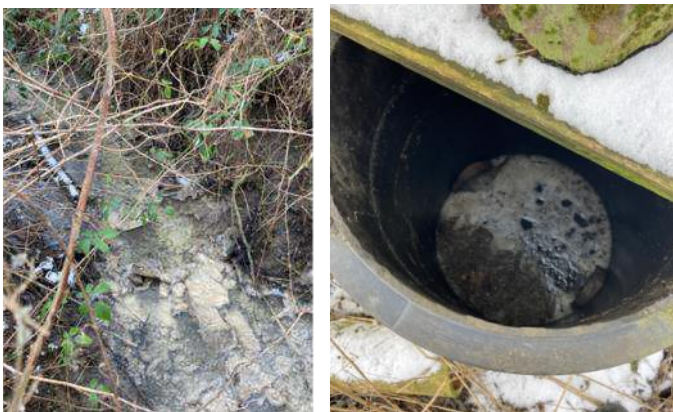
Grøft og drænbørnde med lammehaler
