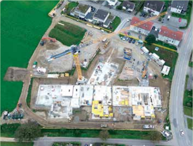
Drohnenaufnahme aus nördlicher Richtung mit fertiger Bodenplatte der Tiefgarage
