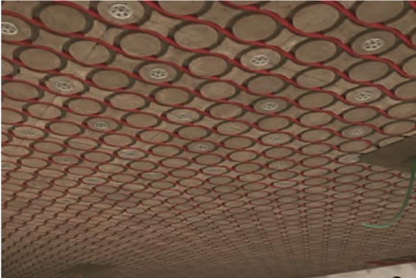
Combinatie van leem-groefplaten en leem-compensatieplaten na het leggen van de buizen
