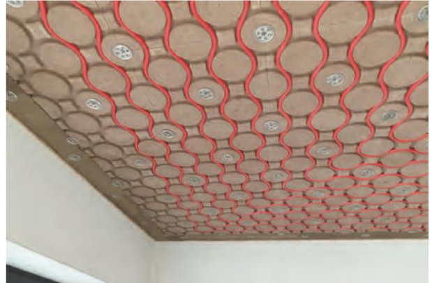
Combinatie van leem-groefplaten en leem-compensatieplaten na het leggen van de buizen
