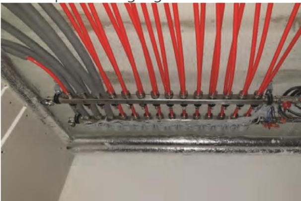
Bevestiging met diverse plafonduitgangen
