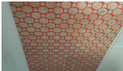
Hoogwaardige leem-modules gelegd met geplaatste koel-/verwarmingsbuis
