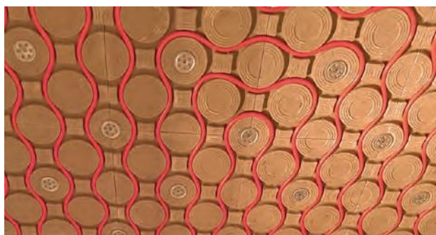
Pose des modules d'argile à haute efficacité, puis montage des installations des tuyaux
