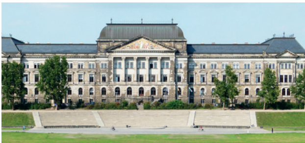
Le ministère des Finances à Dresde : 1.600 m 2 de plafonds réfrigérés sans déshumidification mécanique de l'air
