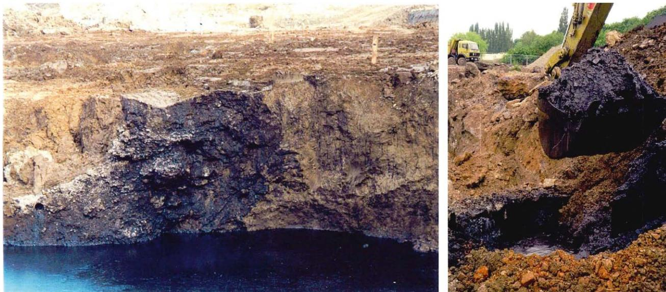
Abbildung 3: Von Teeröl durchsickerter Auelem und Aushub von kontaminiertem Bodenmaterial innerhalb der Dichtwand (© DB AG).
