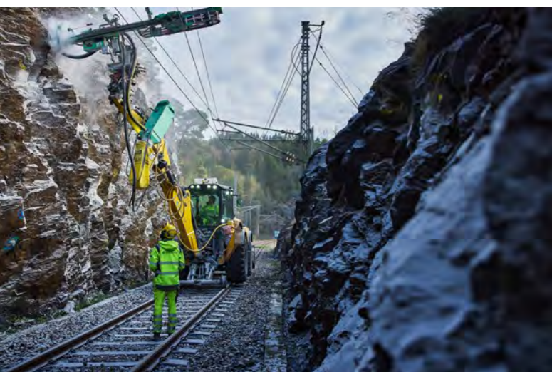
Sikringsarbeider ved Halden på Østfoldbanen
