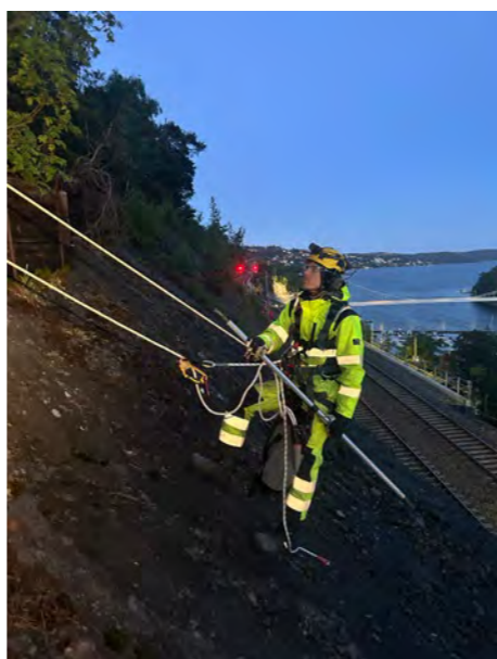
Rassikringsarbeider ved Bekkelaget i Oslo.
