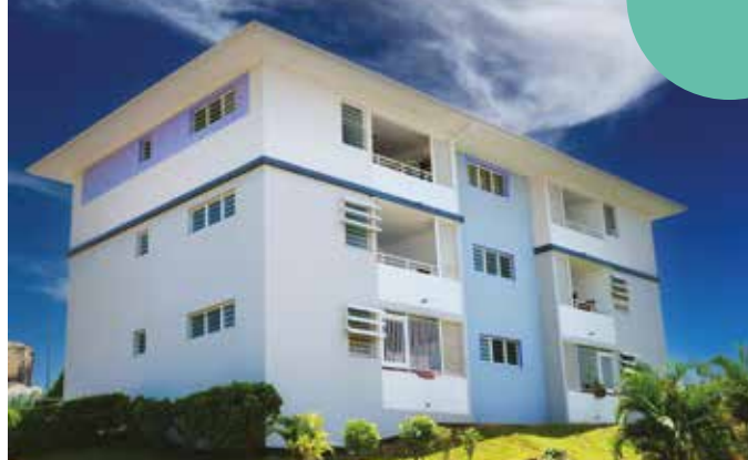
▲ Résidence Ixora, parc de la SIMAR. Architecte : DPLG ETMO. ©S.PLUTON/SIMAR
