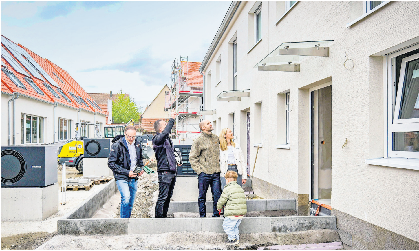
Ein erster Blick aufs neue Zuhause: Der IEP-Geschäftsführer Stefan Schwarz und Bauleiter Silas Kirschner besuchen mit der Familie Hildebrandt (von links) die Baustelle.
