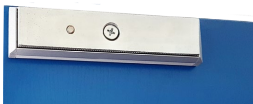
Rys. 19. Blacha montażowa zwory elektromagnesu do drzwi przeciwpożarowych: sposób montażu (a), faktyczny wygląd tak zamontowanej zwory na drzwiach przeciwpożarowych (b) [na podstawie materiałów ID Electronics, zdjęcie autora]
