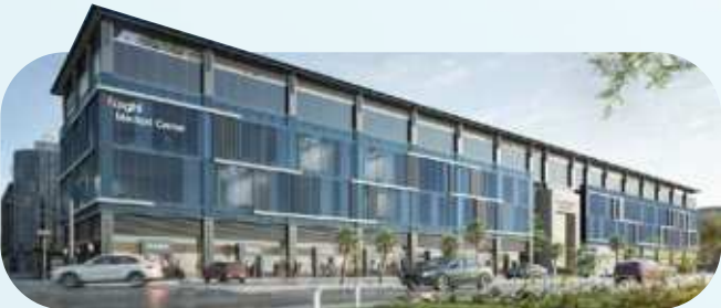
DSFMC Al Zahra, Jeddah
