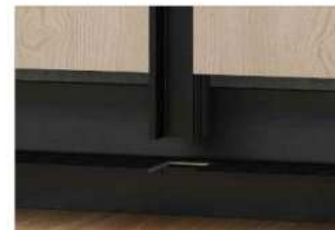
Узел 2 (узел стыка теневой рейки и теневого плинтуса)
