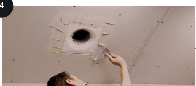
Bereiten Sie eine faserverstärkte Spachtelmasse vor und füllen Sie die Fugen ausreichend aus, um zusätzliche Stabilität zu erzielen. Glätten Sie die Oberfläche auf das Niveau der Gipskartonplatten.
