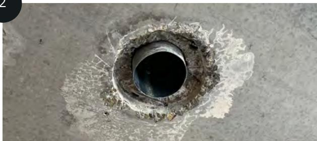
Entfernen Sie nach dem Bohren den Betonring. Setzen Sie anschließend das Lüftungsrohr in die Öffnung ein, um die Montage des Wallflow-Moduls vorzubereiten.
