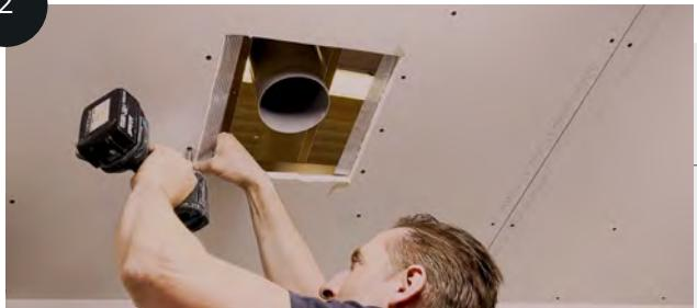
Befestigen Sie die mitgelieferten Montagewinkel **mit der Erhöhung nach unten** in der Öffnung.
