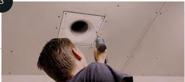
Setzen Sie das Wallflow-Modul in die Öffnung ein und schrauben Sie es bündig mit der Decke oder Wand fest.
