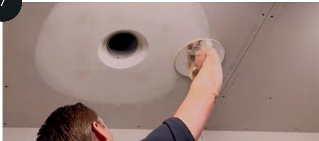
Nach dem Trocknen leicht schleifen und die Oberfläche staubfrei machen.
