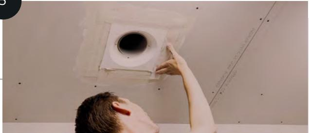
Bringen Sie Fugendeckstreifen über allen vier Fugen an und tragen Sie eine weitere Schicht faserverstärkter Spachtelmasse auf.
