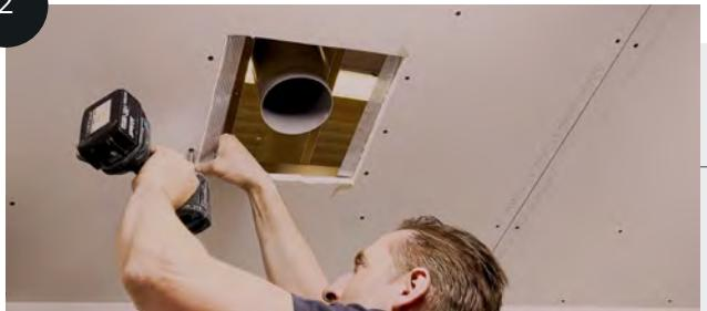
Fixez les plaques de montage fournies dans l'ouverture, **avec la partie surélevée orientée vers le bas**.
