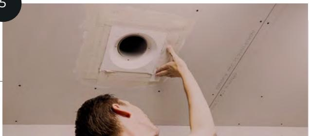
Posez des bandes à joint sur les quatre côtés et appliquez une nouvelle couche d'enduit renforcé de fibres.
