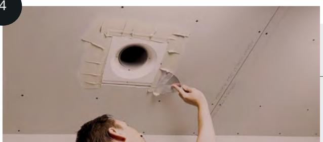
Préparez un enduit renforcé de fibres et remplissez soigneusement les joints pour plus de solidité. Lissez à niveau avec les plaques de plâtre.
