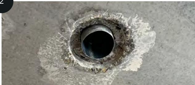
Retirez l'anneau de béton après le perçage. Insérez ensuite le conduit de ventilation dans l'ouverture, en préparation de la pose du module Wallflow.
