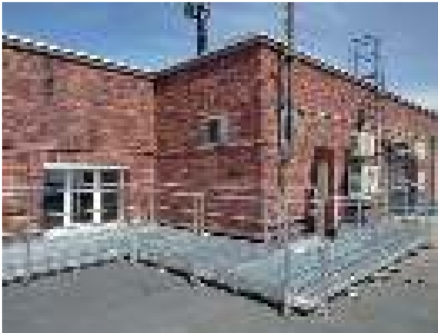
Durchdringungsfreie selbsttragende Konstruktion
