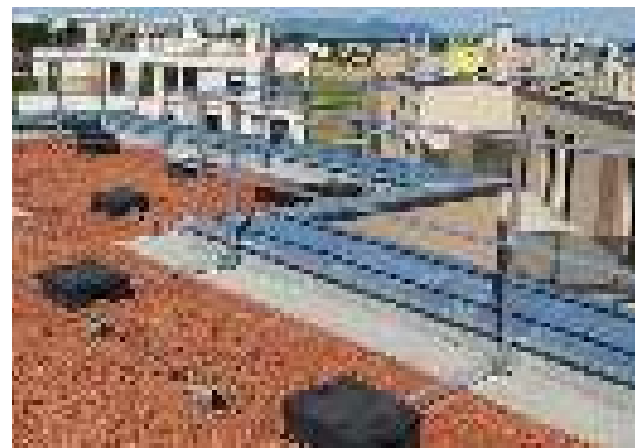
Sicherheitsgeländer selbsttragend Standard als Dachrandsicherung
