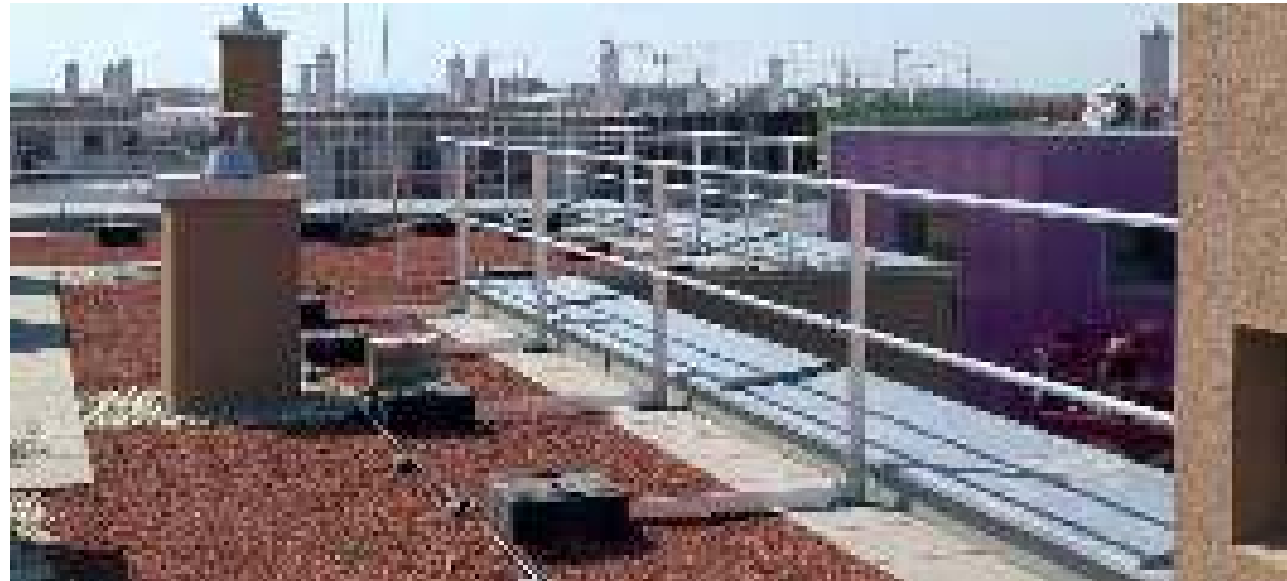
Sicherheitsgeländer selbsttragend Standard
