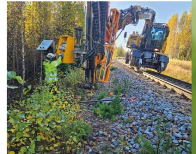
Sondering och provtagning för kontaktledningsbyte med hjälp av borrhaggatet för grävmaskin
