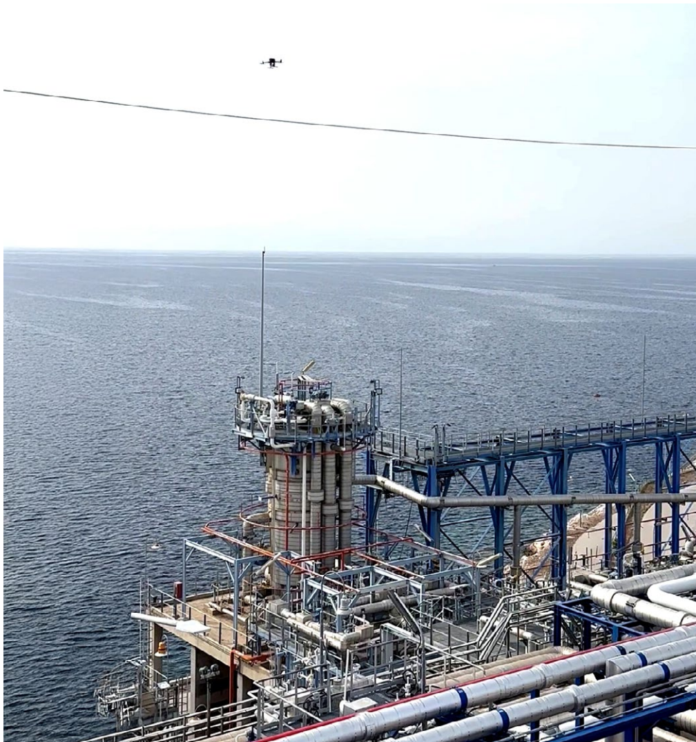
LNG 站点，Ileron 无人机甲烷检测
