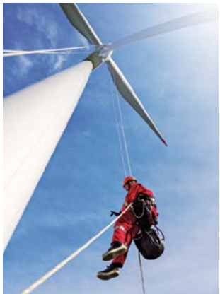
Technicien intervenant sur une éolienne.
