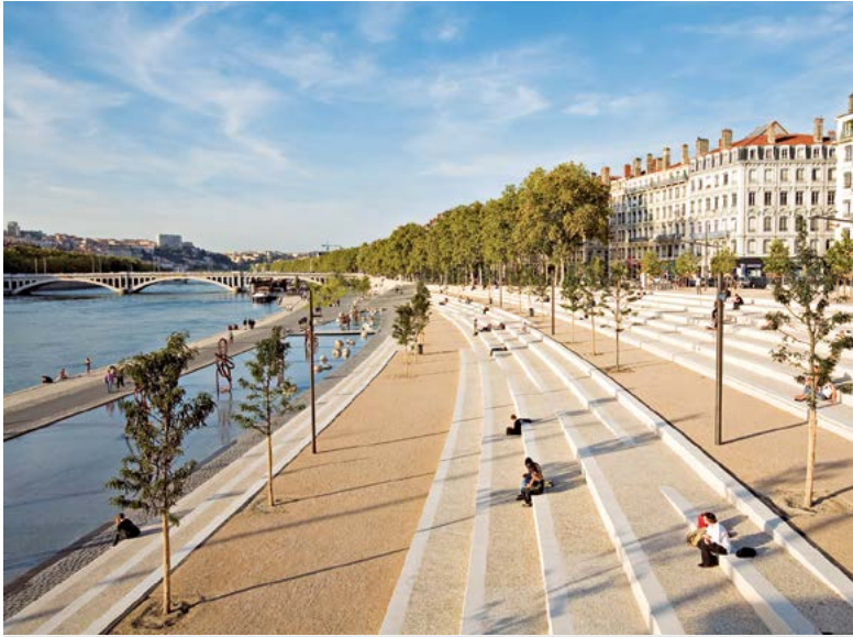
Le quai Victor-Augagneur, un espace réaménagé et végétalisé des berges du Rhône, à Lyon.
