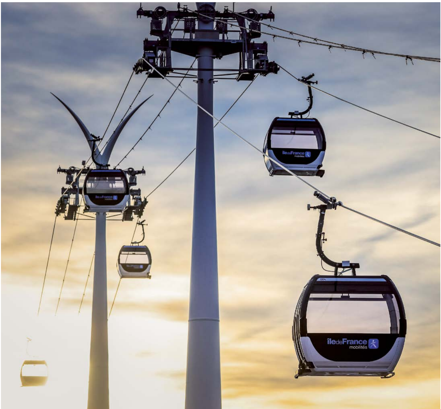
D'une longueur de 4,5 kilomètres, le Câble C1, premier téléphérique urbain d'Île-de-France, situé en banlieue sud de Paris, dans le Val-de-Marne, est en service depuis décembre 2025.
