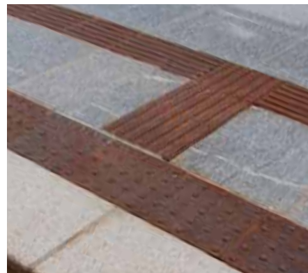
Kunstig ledelinje (retningsindikator) øverst til høyre og farefelt (nederst) ved bane utendørs.
