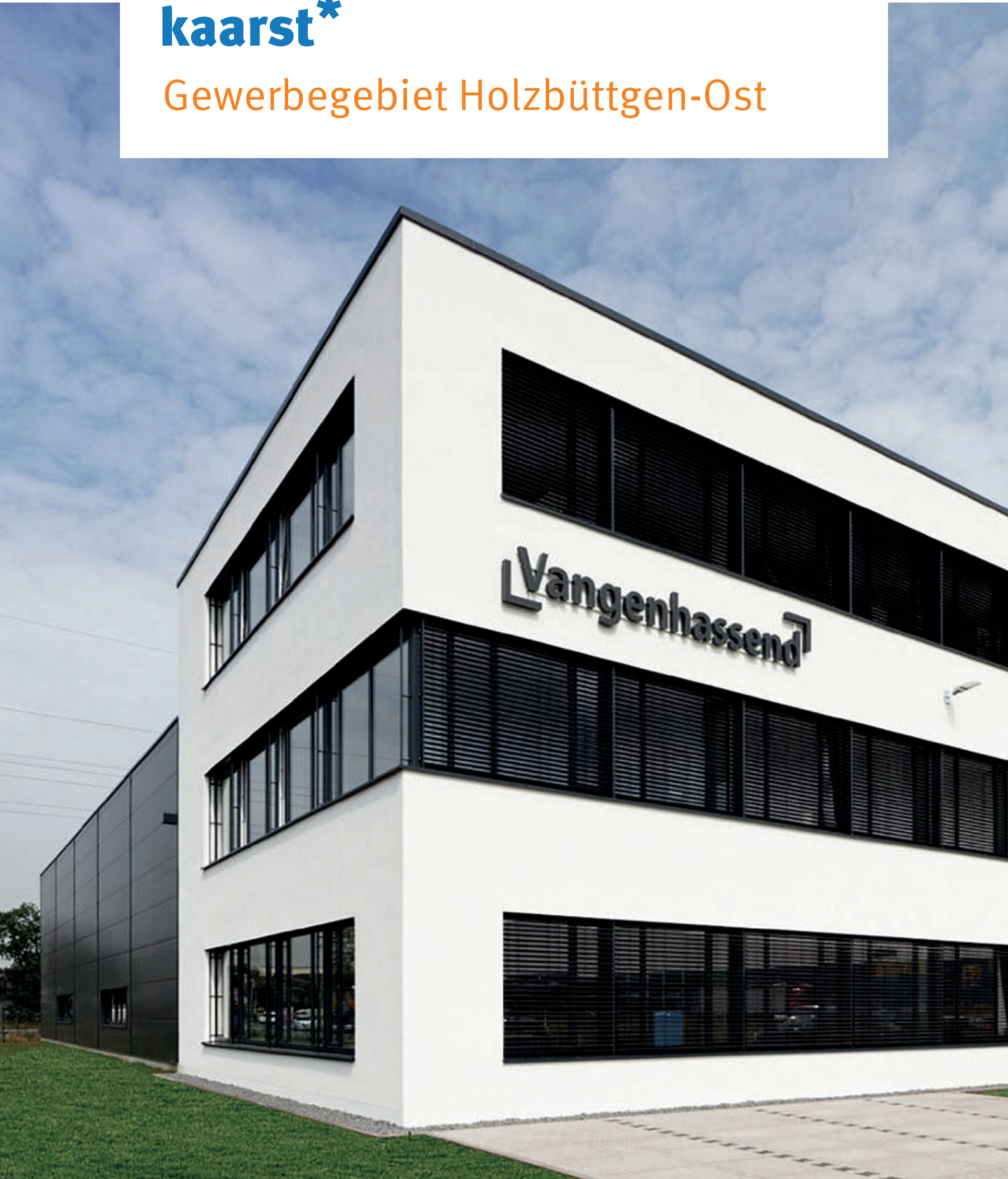
Neubau Gewerbegebäude mit Halle in Holzbüttgen-Ost
