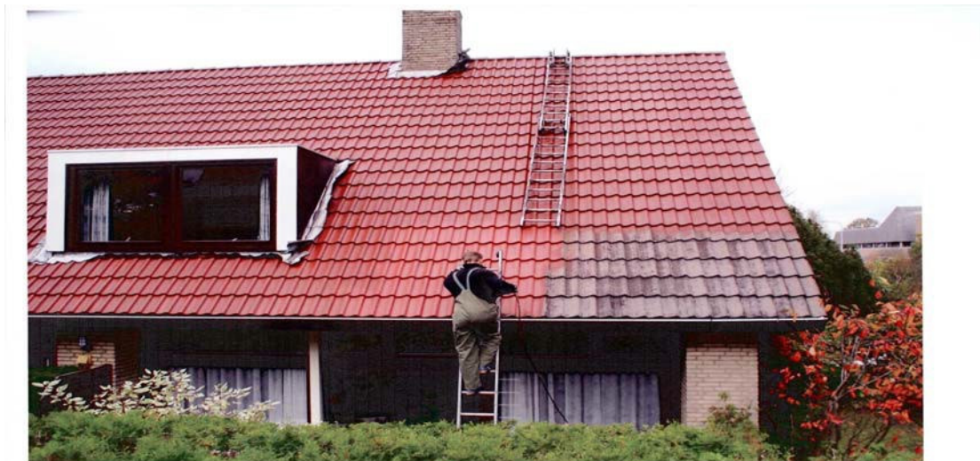
Dachsanierung – rechts unten = unbehandelte Fläche
