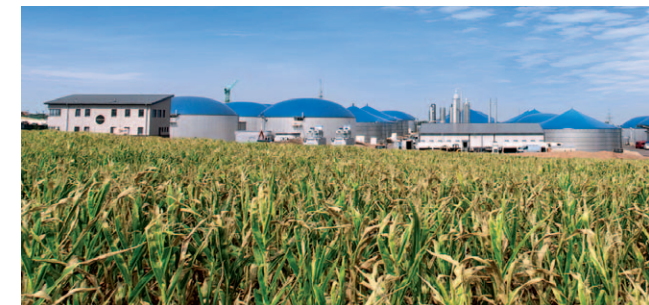
Bio-Raffinerieanlage in Könnern, Gesamtleistung: 17,5 MW therm.
