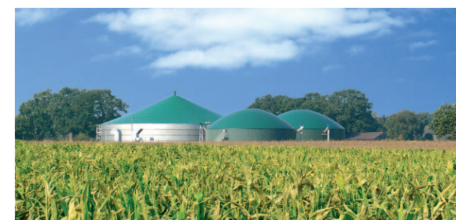
Installation de biométhanisation agricole dans le Oldenburger Münsterland (Allemagne du Nord)
