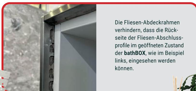
Die Fliesen-Abdeckrahmen verhindern, dass die Rückseite der Fliesen-Abschlussprofile im geöffneten Zustand der **bathBOX**, wie im Beispiel links, eingesehen werden können.
