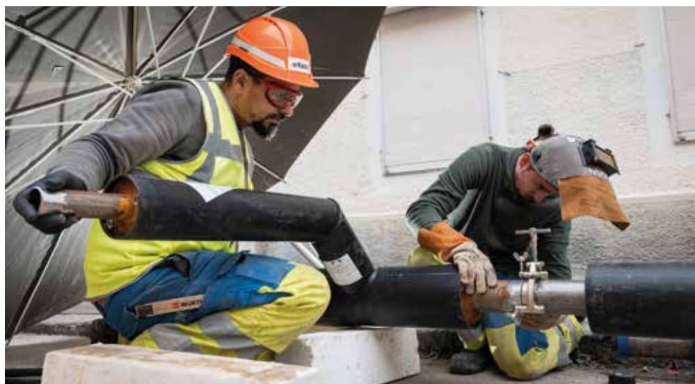
Installation du chauffage à distance.
