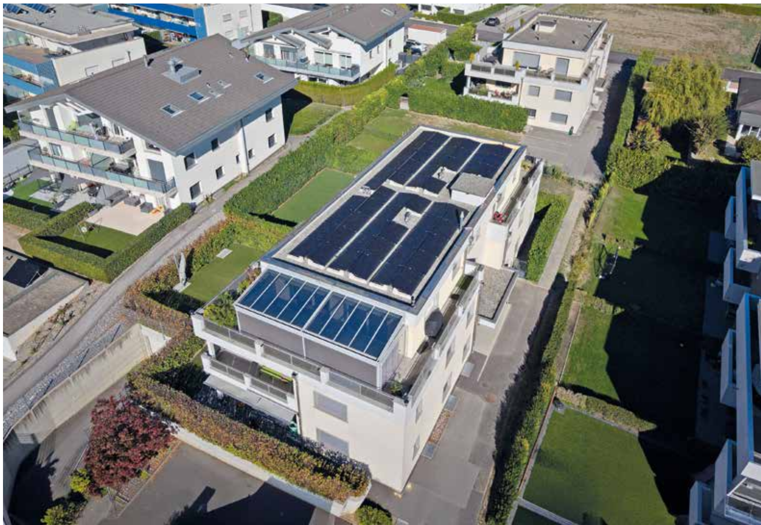
Production solaire sur l'immeuble Pollux, à Vétroz, partagée avec les bâtiments voisins.
