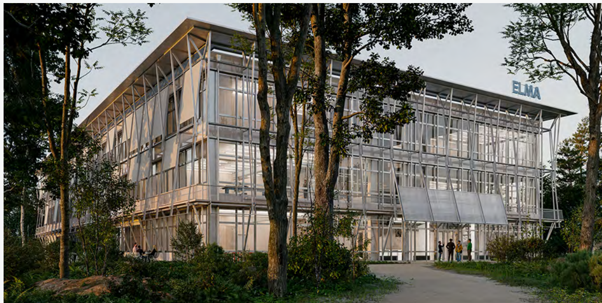
© Wetzikon: Erweiterung in Leichtbauweise bei bestehender Betonstruktur
