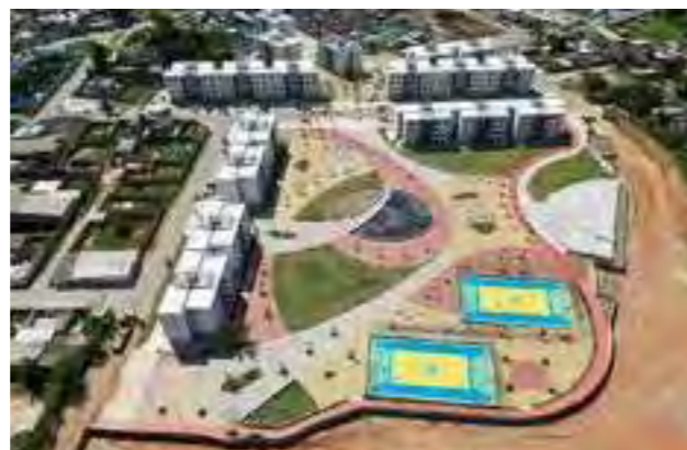
As obras da Comunidade do Aço avançam desde os blocos de apartamentos até a infraestrutura
