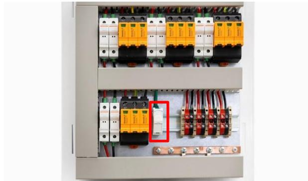
De esta manera, el instalador deberá conectar el meter directamente al conector RJ45 incluido en el Sunbox. Para realizar la conexión, el cable del meter debe ser introducido por la parte inferior del Sunbox (Instalación de cableado CC) y se debe retirar la cubierta de protección CC (Acceso a las protecciones DC).
