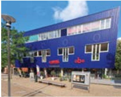
Kantoor Welzijn Diemen in gebouw de Omval
