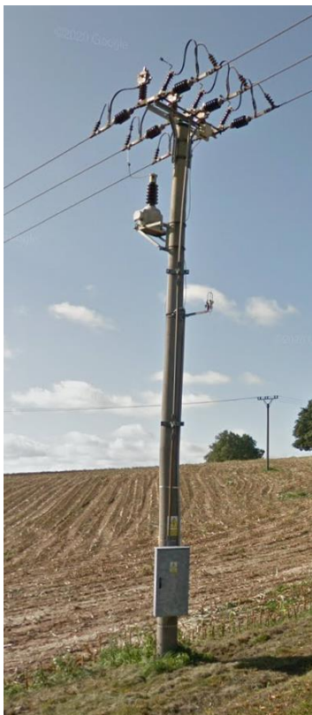
Obrázek 1: Vlevo: DOÚS, vpravo recloser
