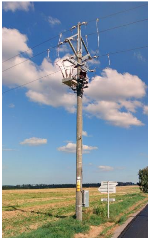
Obrázek 1: Vlevo: DOÚS, vpravo recloser
