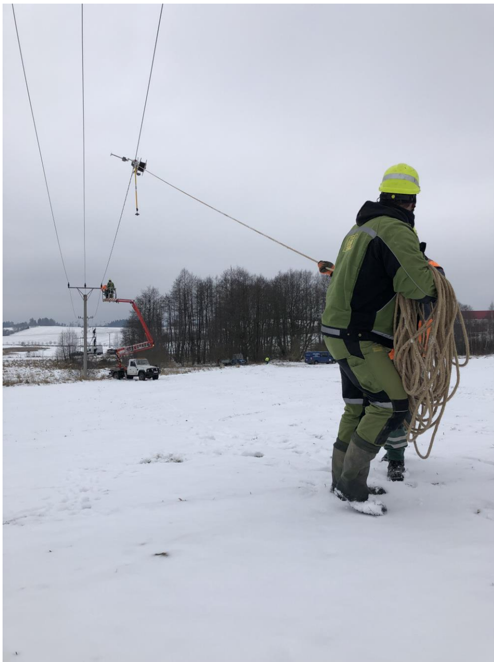
Obr. 4 – Instalace optického vodiče
