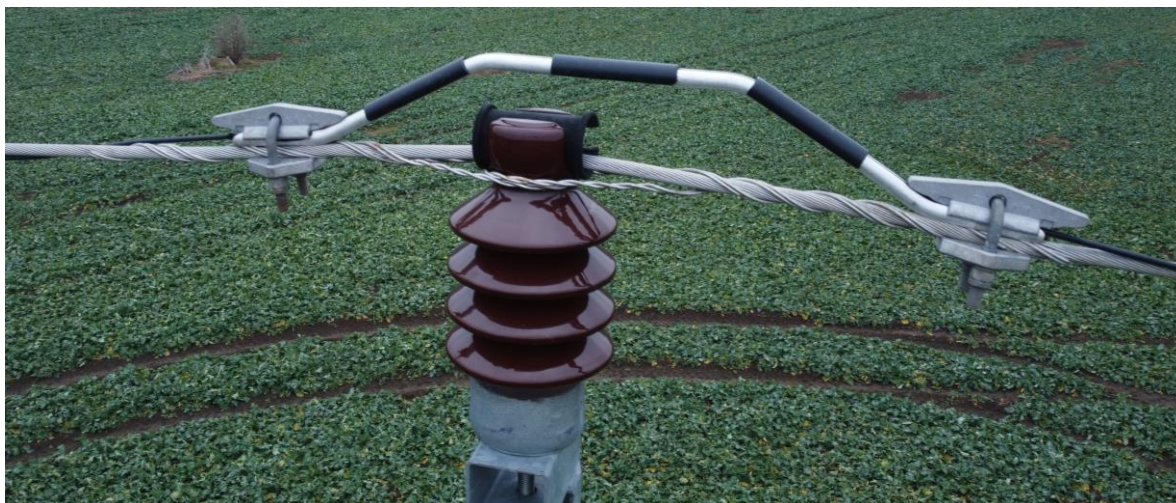
Obr. 5 – Detail přechodu přes izolátor
