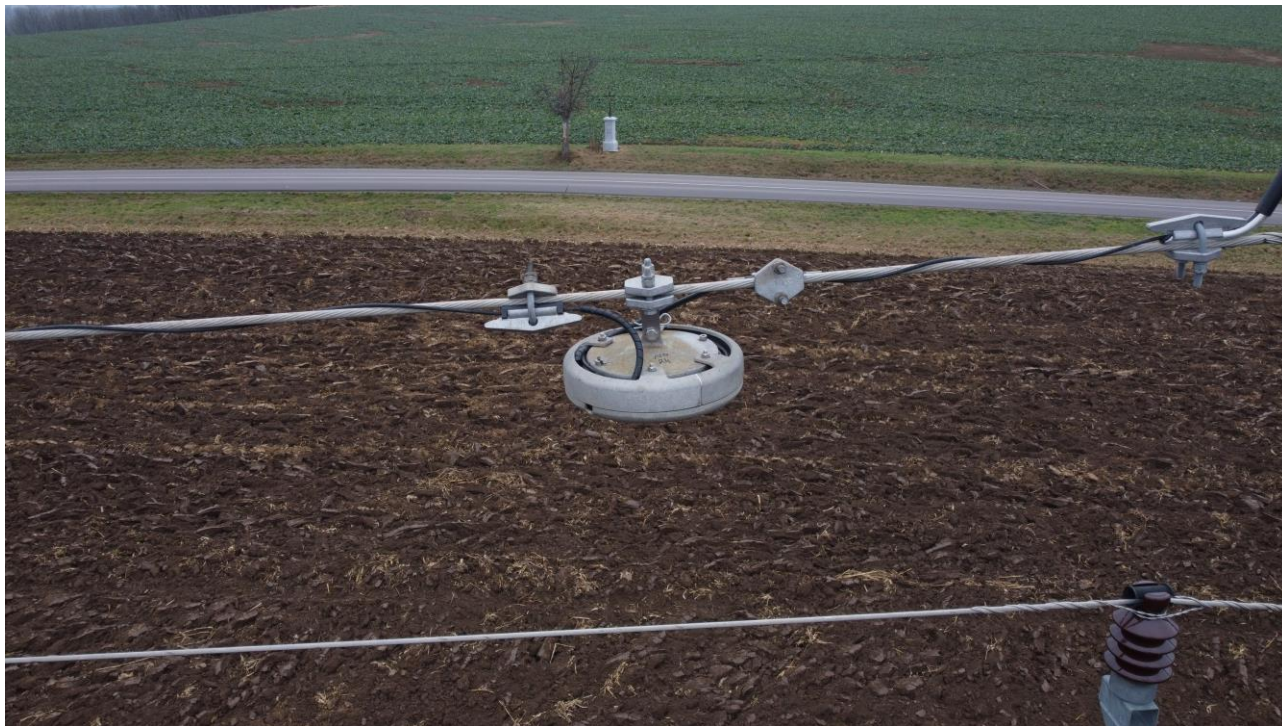
Obr. 7 – Talířová spojka uchycena přímo na vodiči
