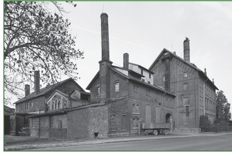
22 Bockenem, ehemalige Brauerei Hein, Remise, Sudhaus, Mälzerei und Wohnhaus, Maurermeister Hunger, 1886–88
