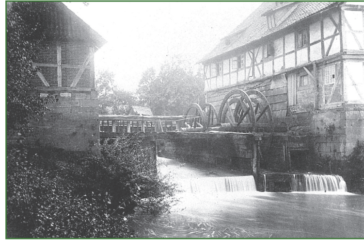
20 Kreiensen-Greene, Wassermühle Warnecke vor ihrem Abbruch zugunsten des 1901/1902 errichteten Wasserkraftwerks
